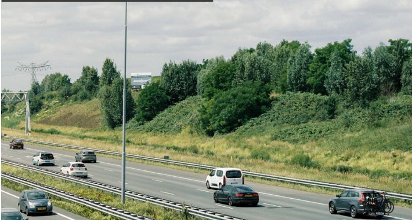
Natuurlijke geluidswal die Grondbank GMG aanlegt bij Beuningen (Gld)
